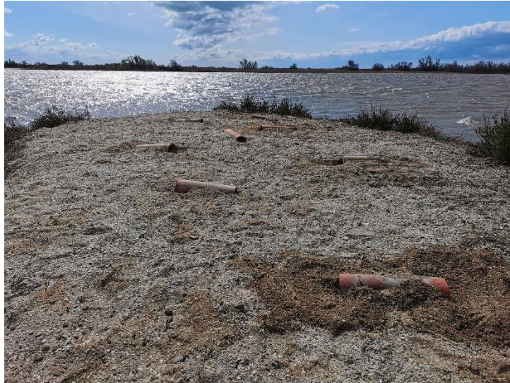
Figure 29 : Îlot de la Baisse Claire après arrachage de la végétation, apport de sable coquillé et mise en place de petits aménagements pour la protection des poussins ©ML Degez PNRC, 2022.
