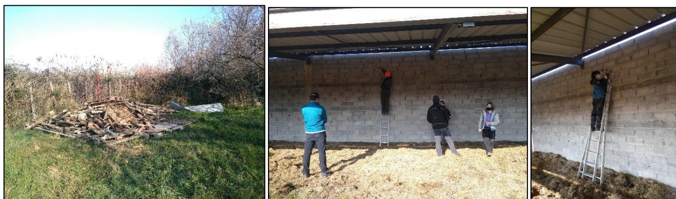
Illustration 39 : Garenne en cours de construction (à gauche). Elèves GMNF créant des gîtes à chauves-souris (à droite) ©L.Poulet, PNRC 2022.
