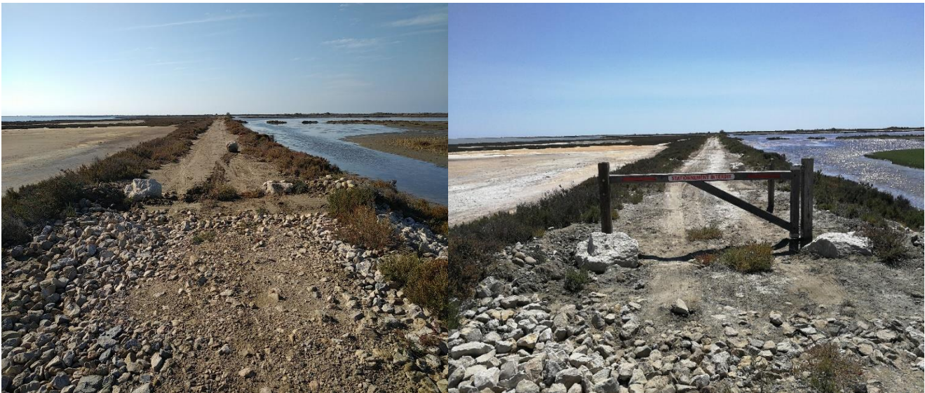
Illustration 15 : Avant et après la pose de la barrière Vaisseau 1/Vaisseau 2 ©P.Rigaud, 2022.
