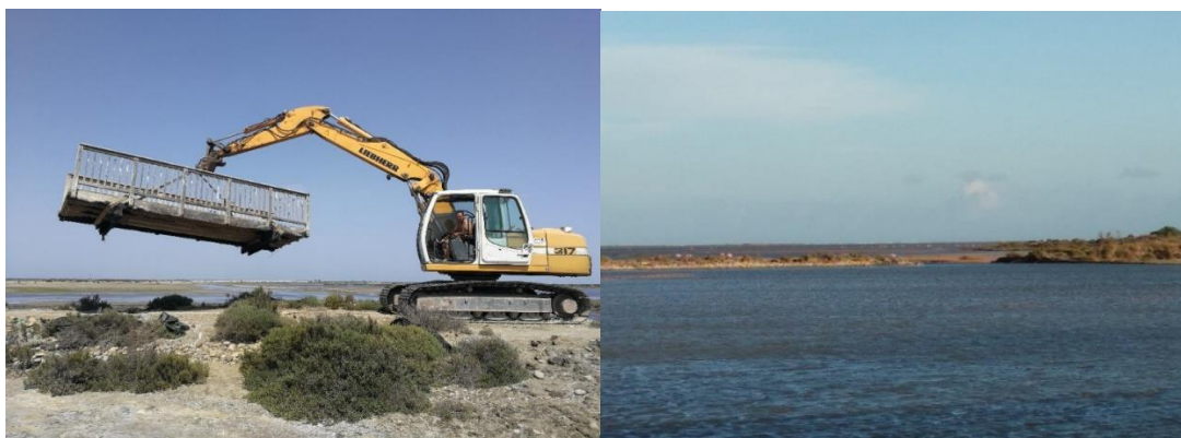
Illustration 12 : Enlèvement de la passerelle Beauduc Nord / Vaisseau Nord ©P.Rigaud, 2022.
