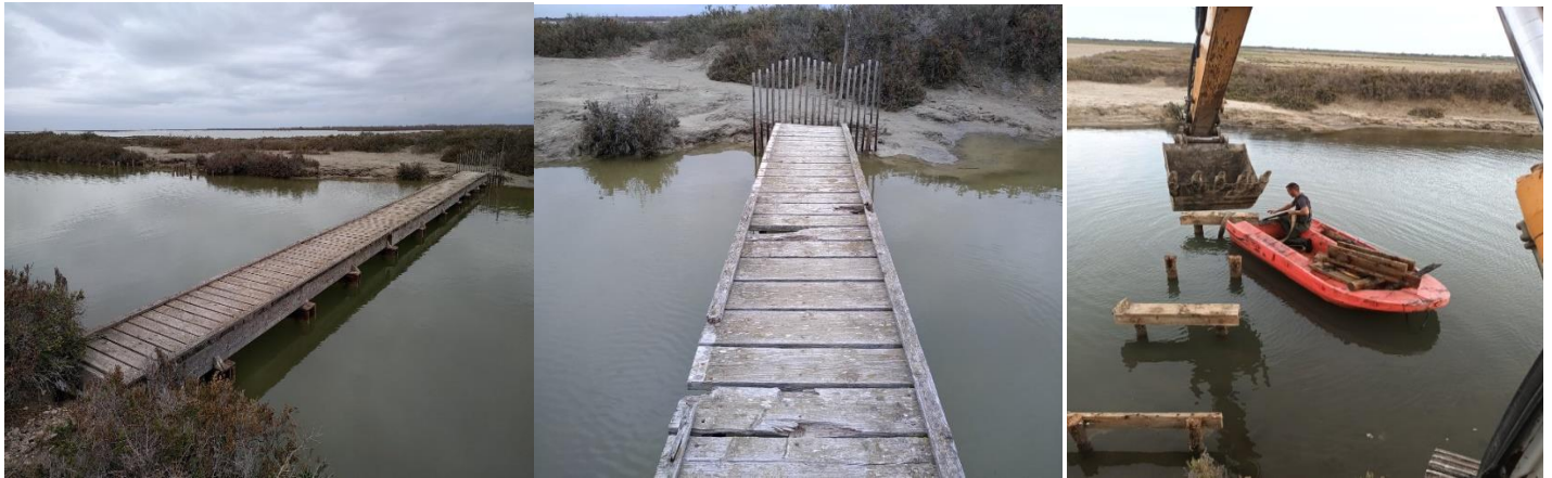
Illustration 11 : Enlèvement de la passerelle du canal d'évacuation du Fangassier ©P.Rigaud, 2022.
